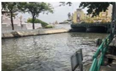
สถานีที่ 1 สะพานผ่านฟ้า
