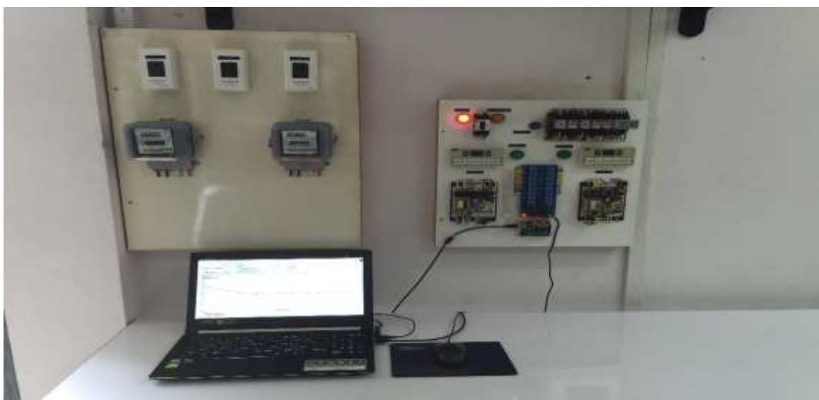
ภาพที่ 4 ระบบควบคุมที่ออกแบบและสร้างขึ้นมาใช้ในการทดลอง ที่มา : ภาพถ่ายโดย บัณฑิต จิตต์สุภาพ เมื่อวันที่ 17 มิถุนายน พ.ศ. 2562
